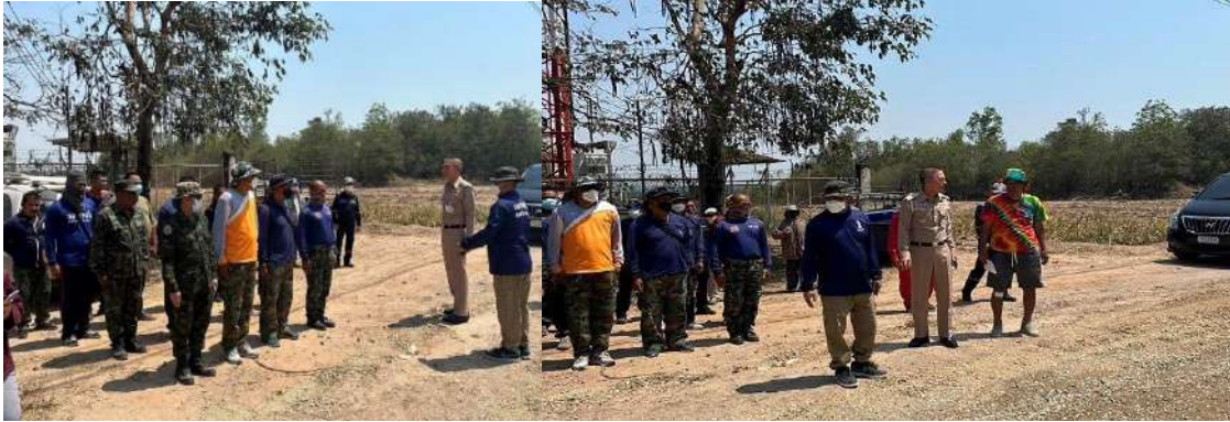
ภาพ ข-3 ผบ.ฐท.สส. ตรวจสอบพื้นที่การปักเสา พาดสายไฟฟ้า และปรับปรุงถนนรวมทั้งปัญหาขยะชุมชนในหมู่บ้านมั่นคง
